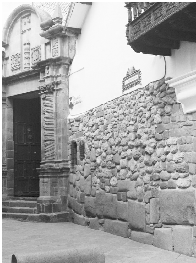
Diferentes técnicas constructivas en un mismo muro.
